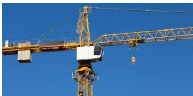
Equipamentos de construção
